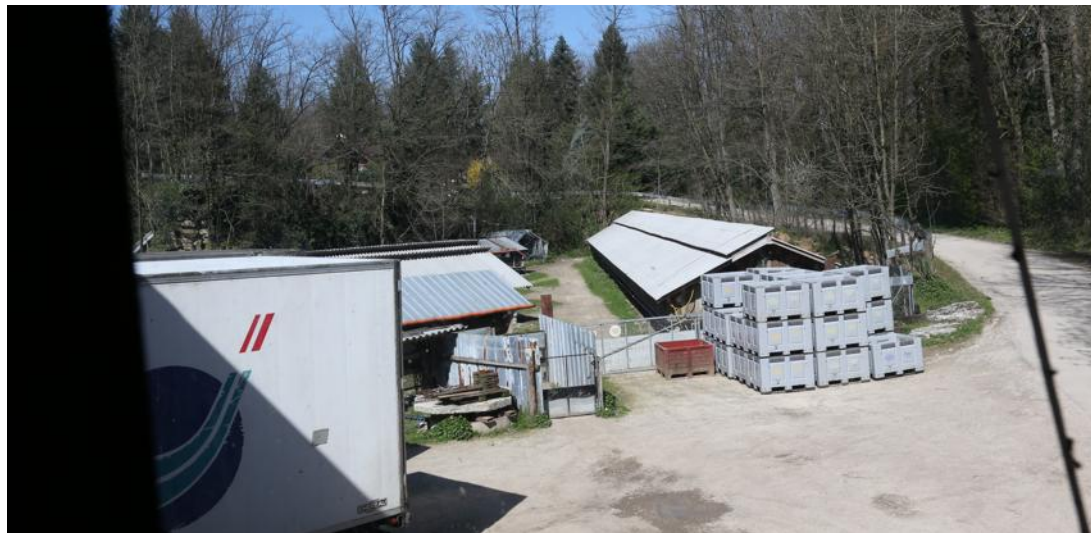
Les installations déjà existantes au lieu-dit Charmot-Dessus, à l'écart d'Émagny, sont vides depuis des mois (le cliché date du 28 mars dernier). Photo Arnaud CASTAGNÉ
